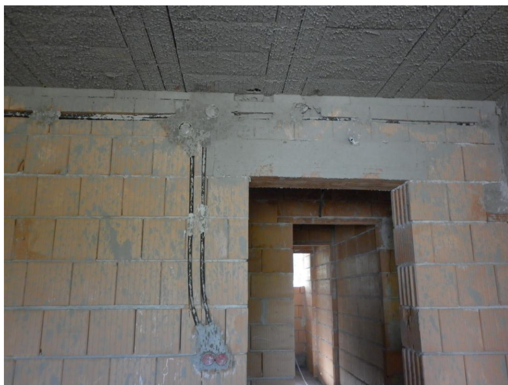
45. ábra Villanyvezetékek falba süllyesztése II.
