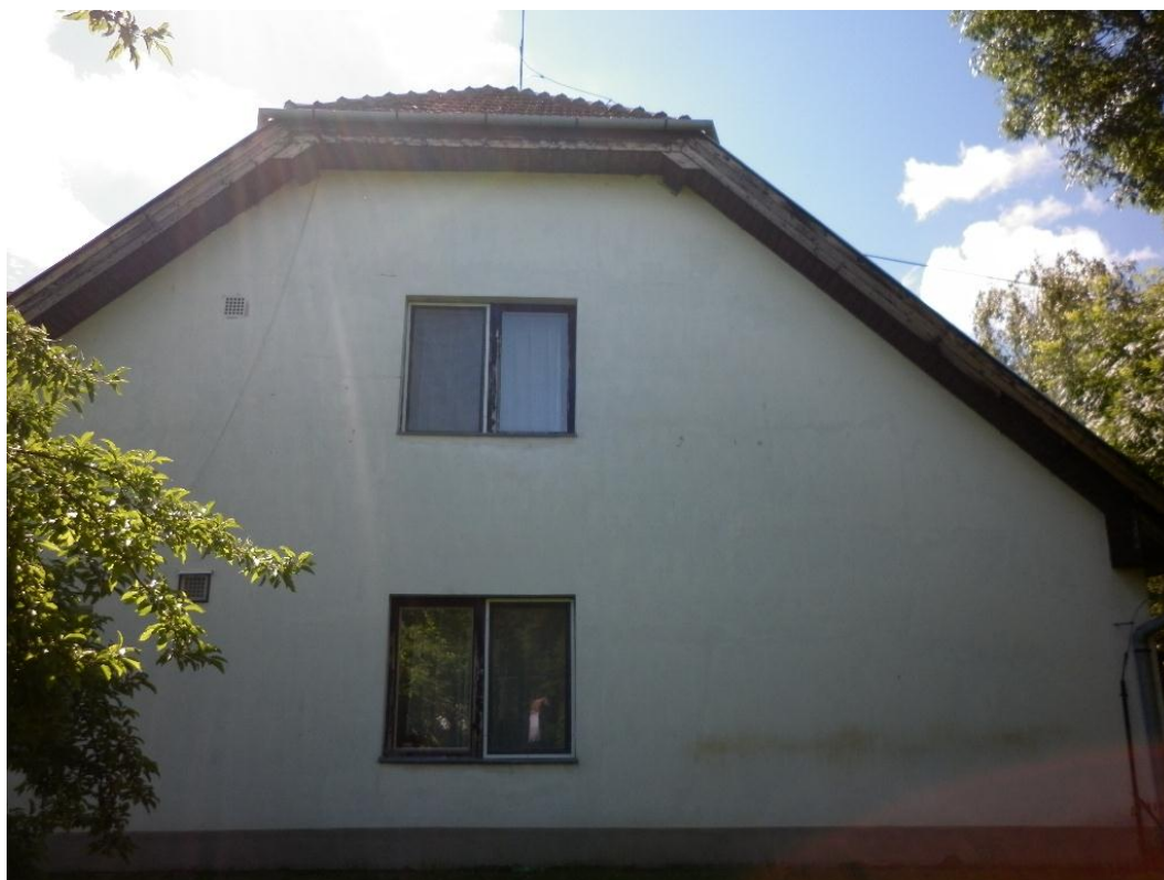
14. ábra A bővítendő épület végfala - csatlakozási pont_04
