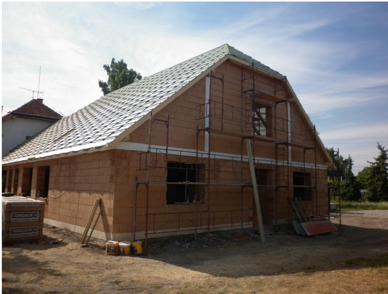
39. ábra Héjazat szigetelése és állványozás
