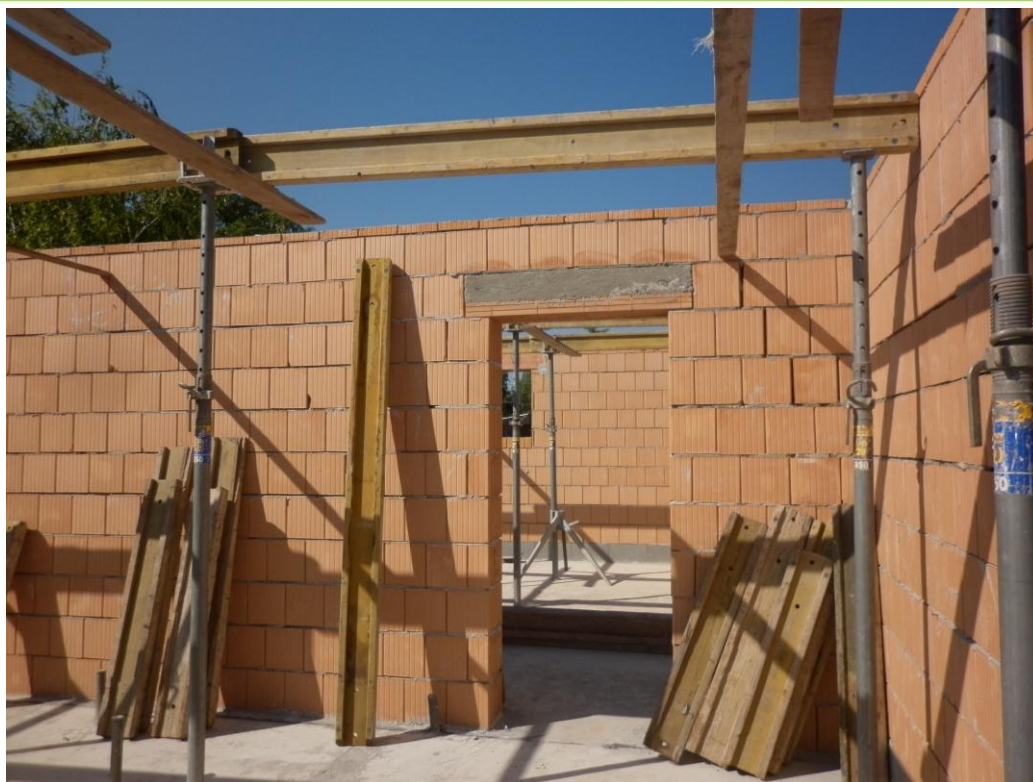
31. ábra Tartófalak és nyílások kialakítása
