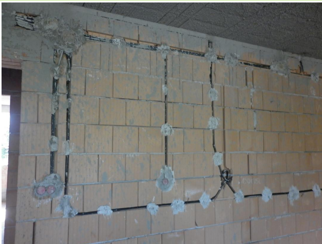
44. ábra Villanyvezetékek falba süllyesztése I.
