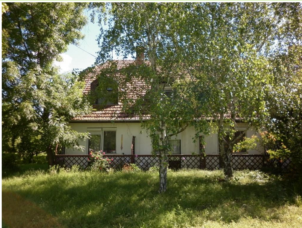
6. ábra A bővítendő épületszárnyban a Szeretetotthon lakói kaptak elhelyezést
