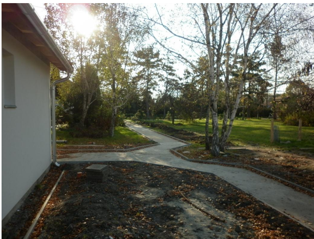
48. ábra Járdák előkészítése
