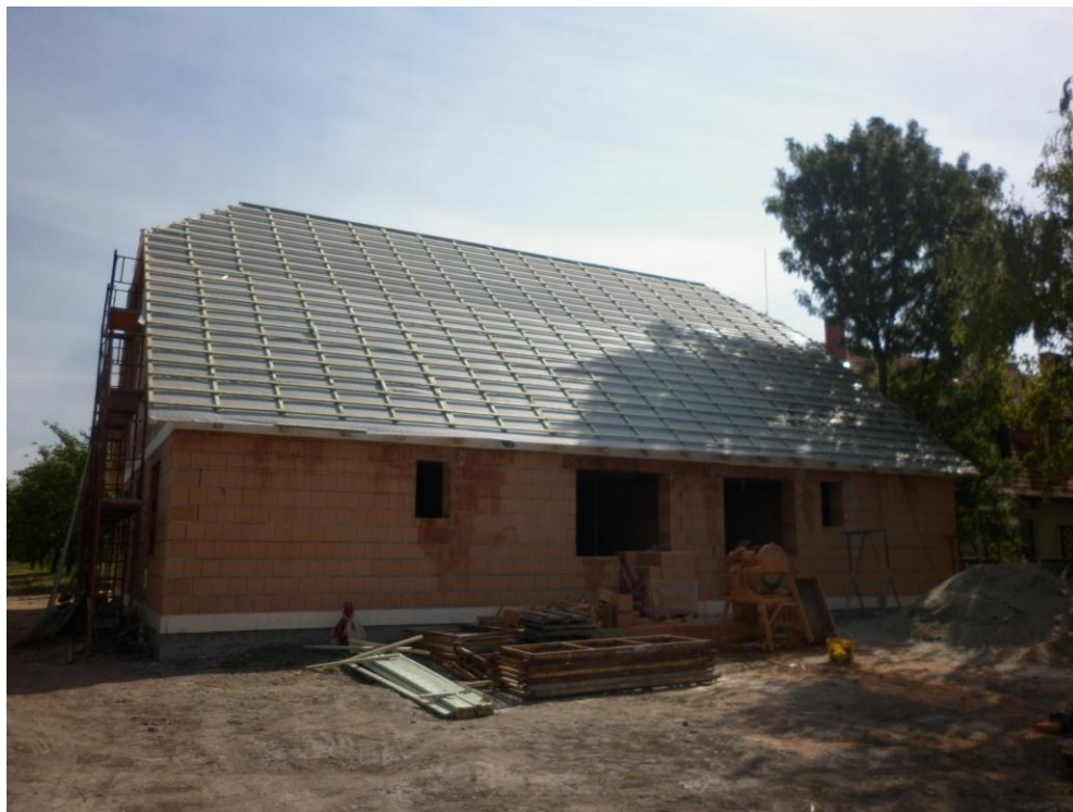
33. ábra Tetőhéjzat készítése
