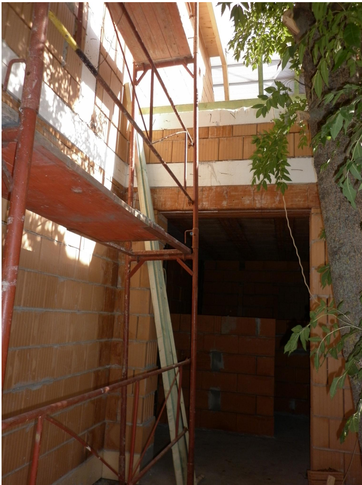
35. ábra Állványozás a jövőbeli AKM bejáratnál
