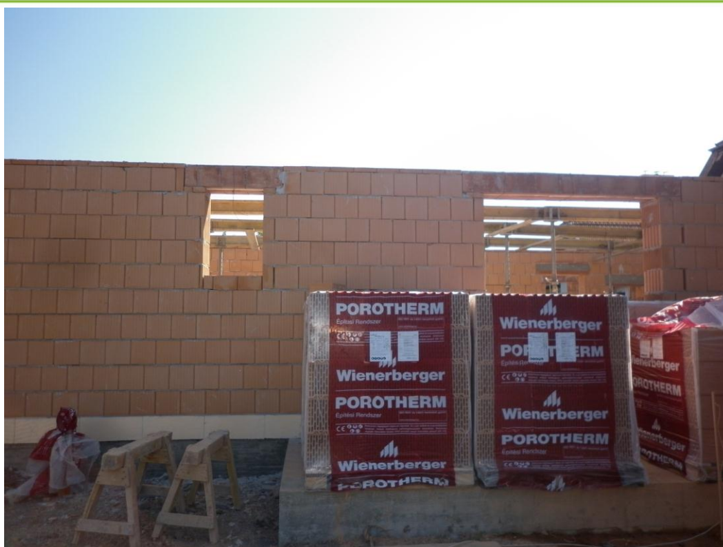
27. ábra Falazat készítése
