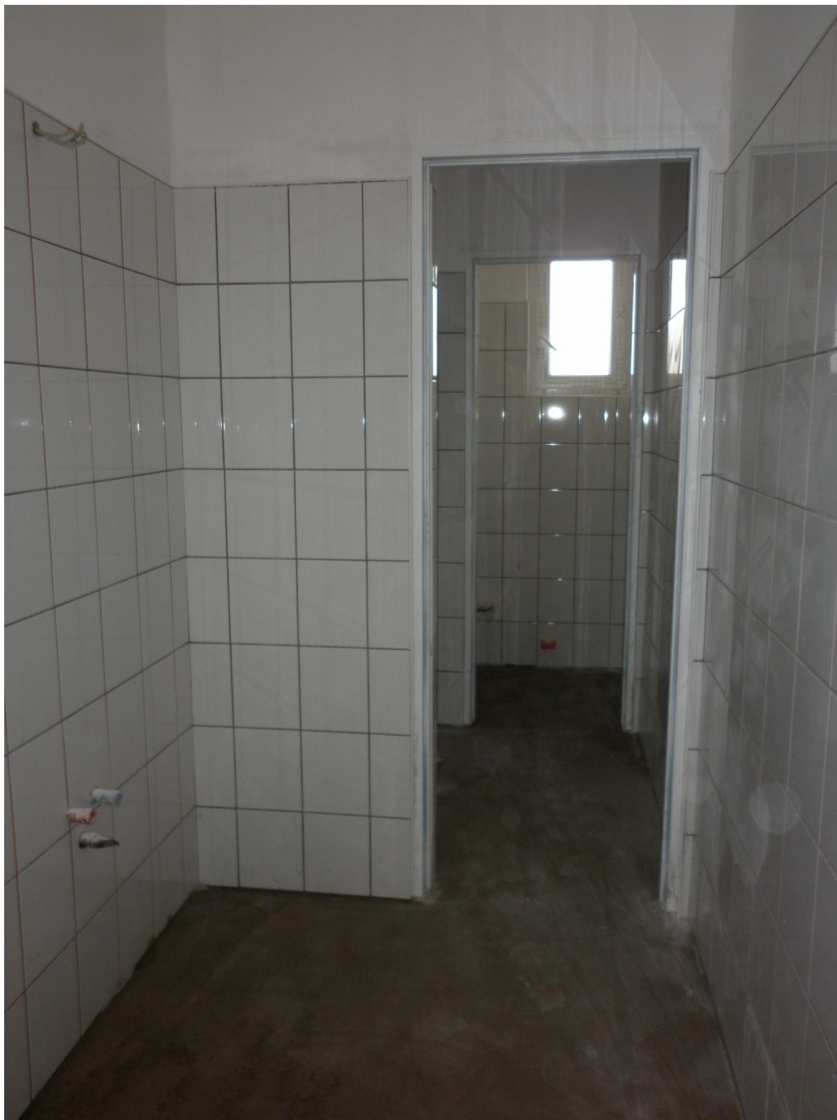
53. ábra Vizes blokkok burkolása, előkészítése
