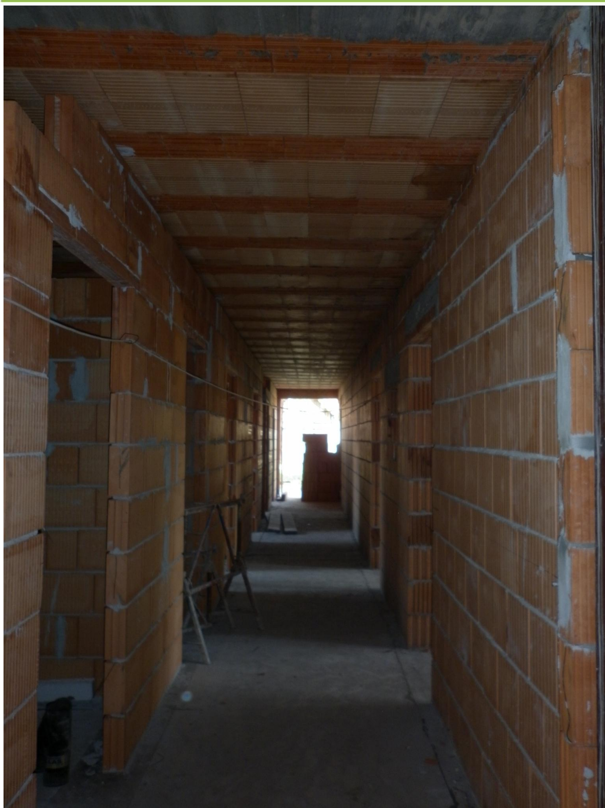
36. ábra Fő közlekedési út, folyosó
