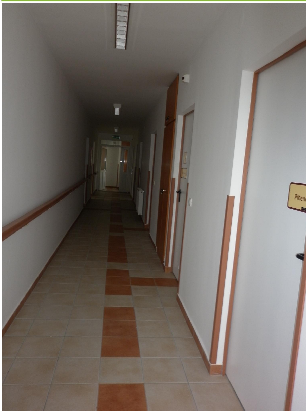
56. ábra Folyosó vezetősávval
