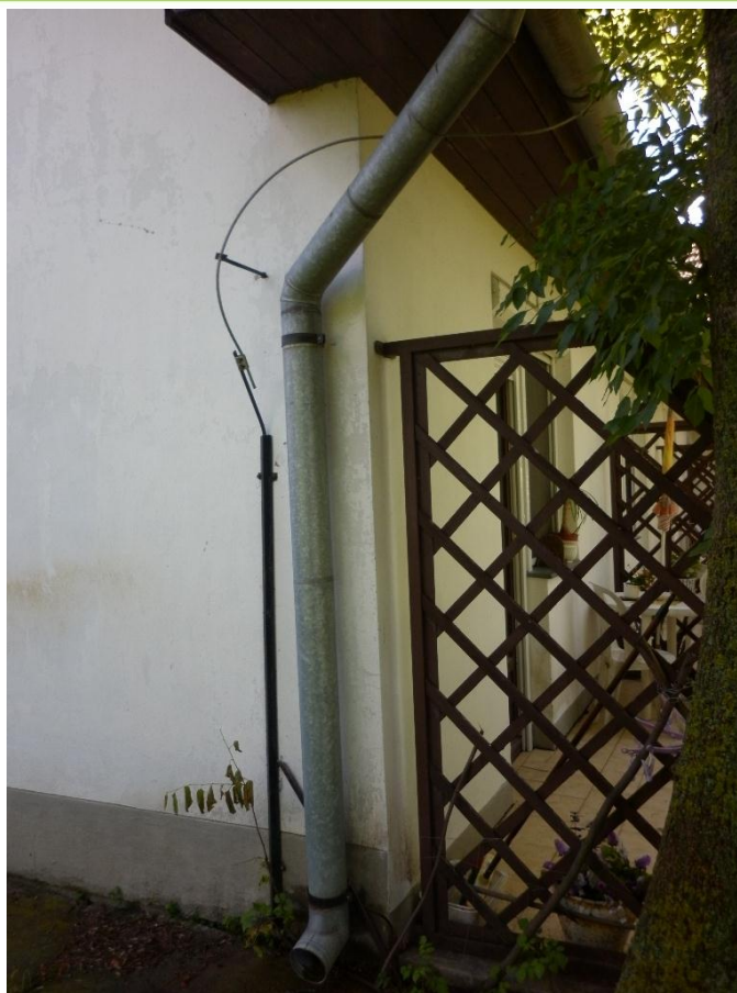
10. ábra A bővítendő épület sarka - csatlakozási pont
