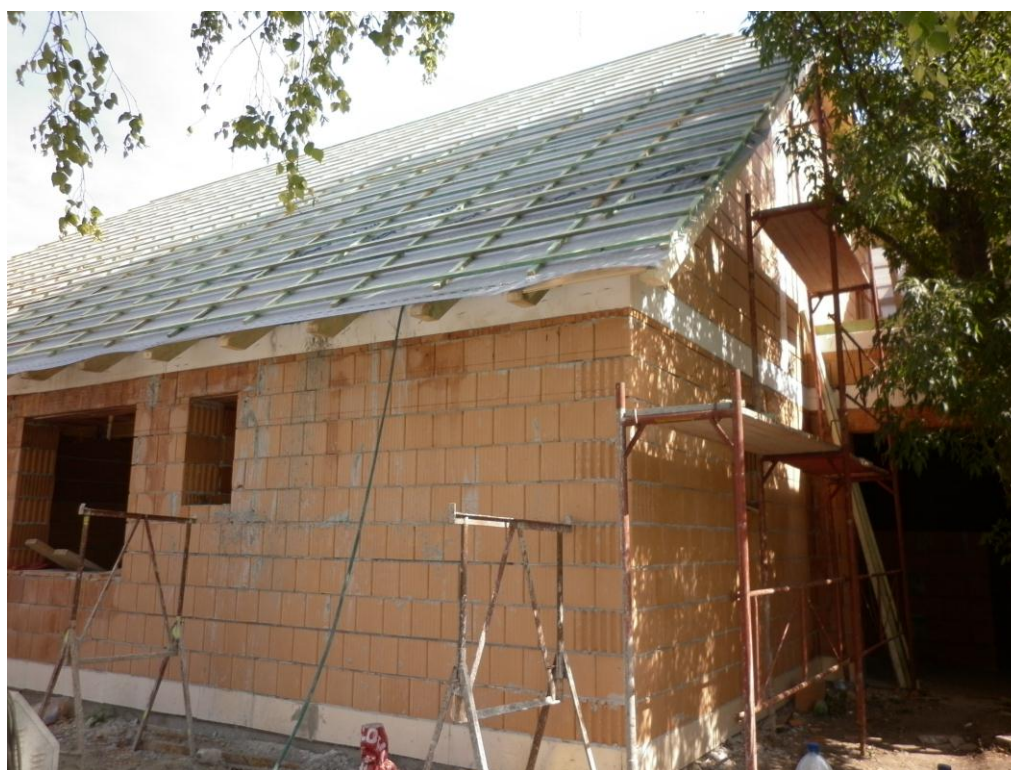
34. ábra Tetőhéjzat szigetelése
