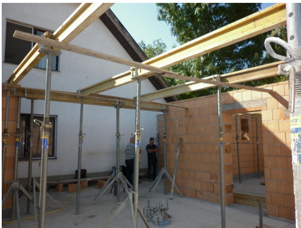
32. ábra A földémszerkezet előkészítése
