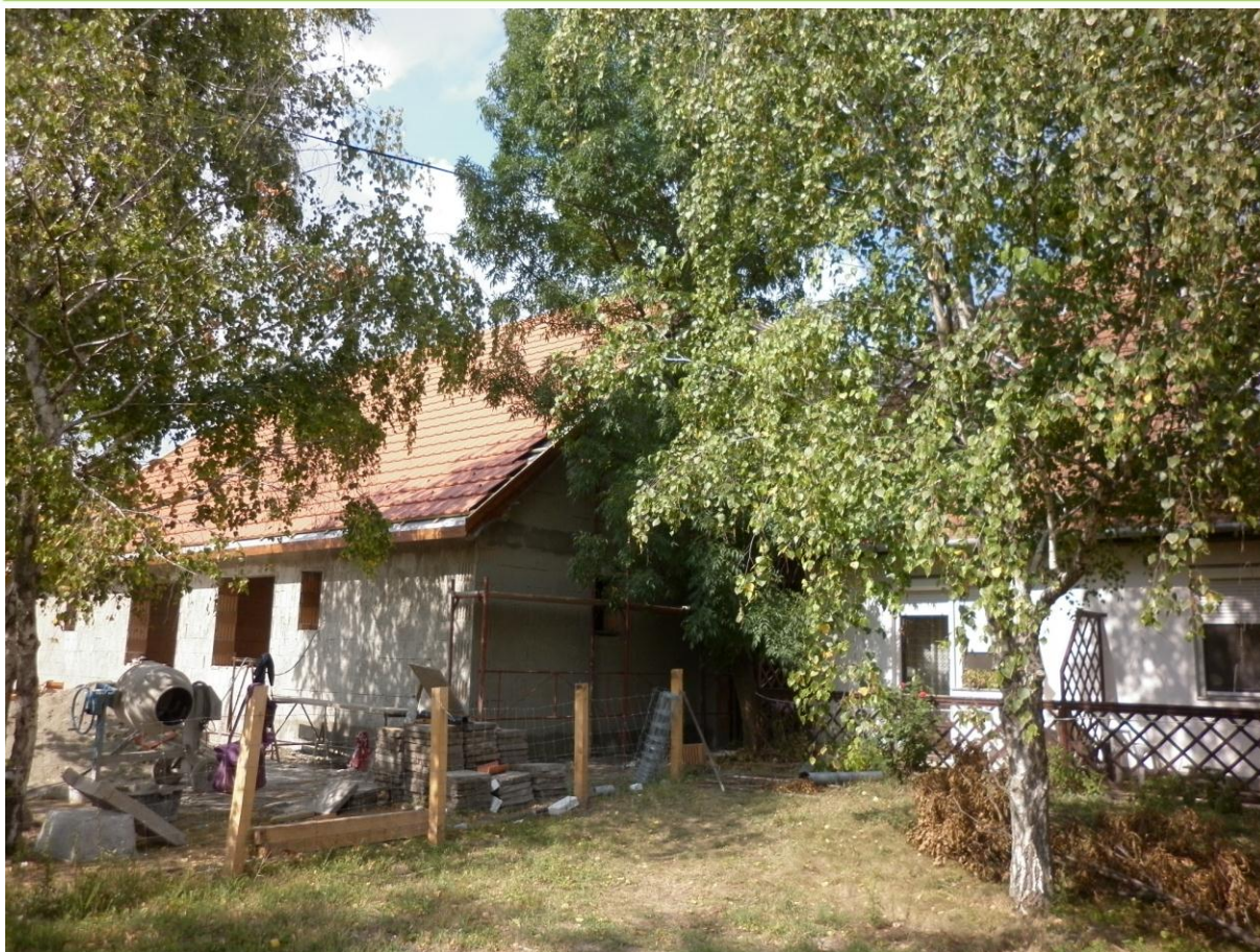
46. ábra A munkaterület és az üzemelő Szeretetszolgálat elválasztása
