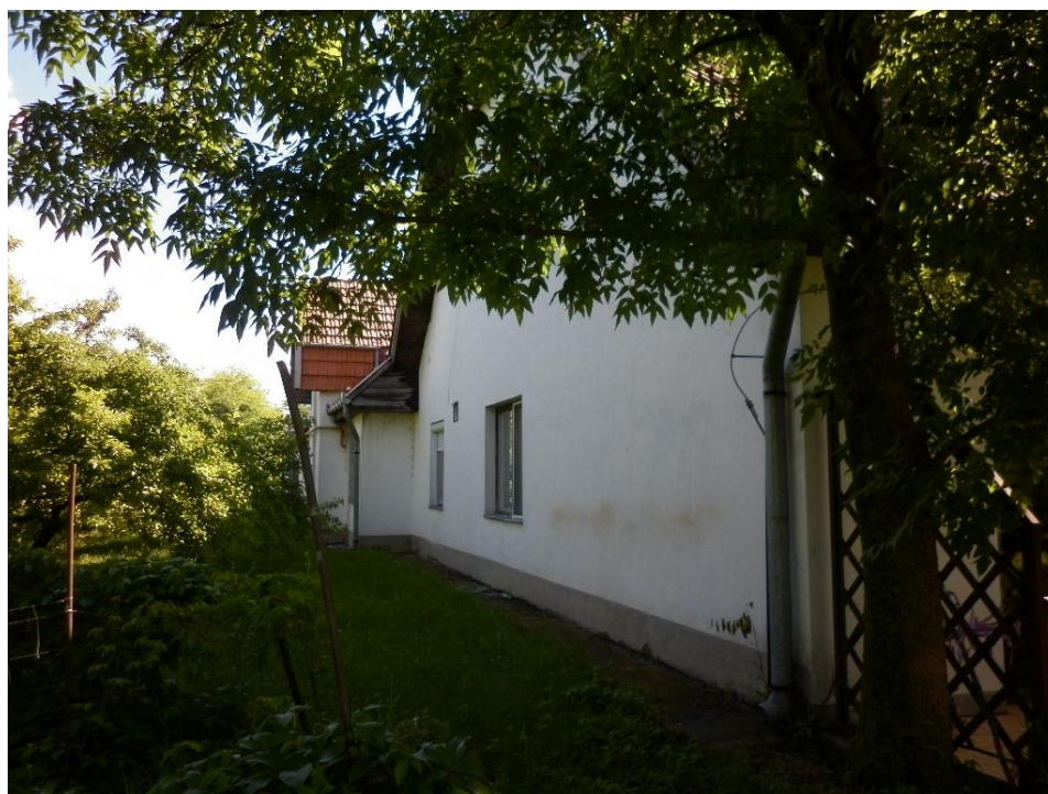
11. ábra A bővítendő épület végfala - csatlakozási pont_01
