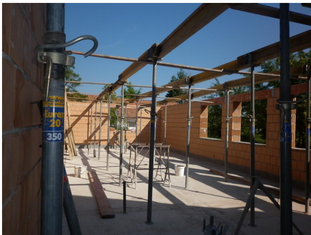
30. ábra Tartószerkezet összeállítása a földem előkészítéséhez
