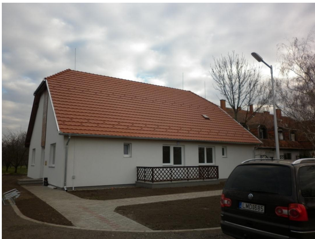
58. ábra Épület megközelítése a parkolóból
