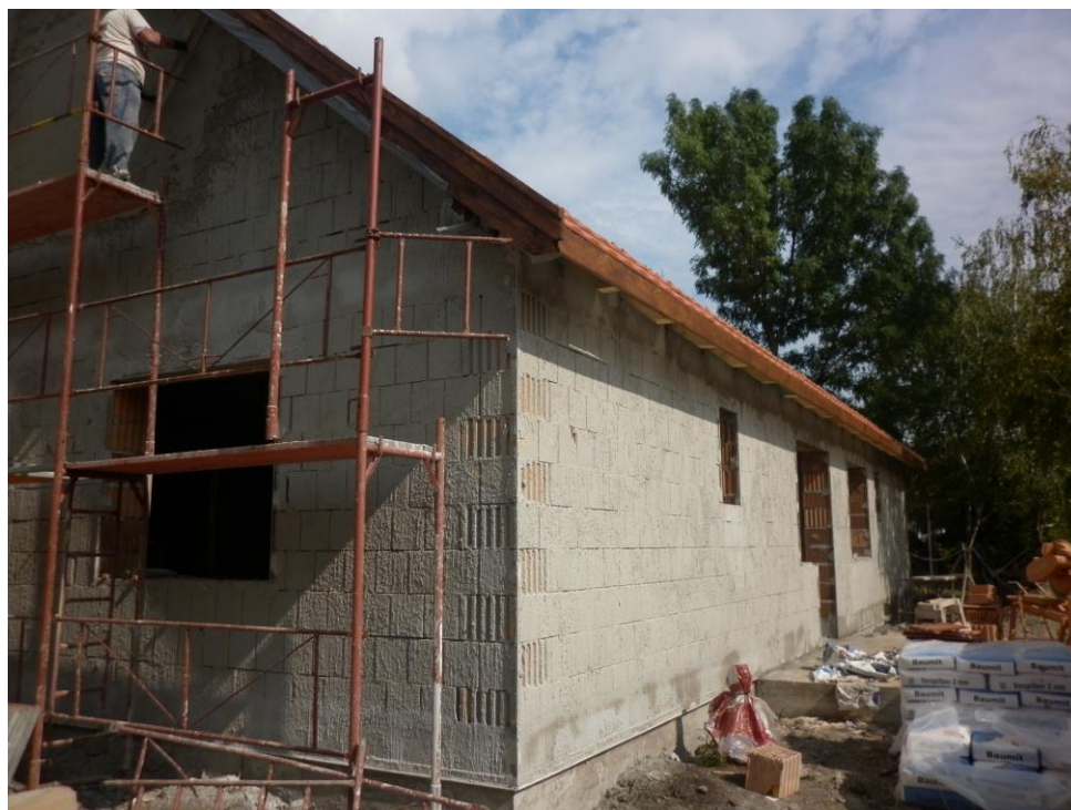
41. ábra Külső felületképzés előkészítése
